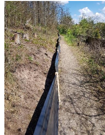
Abbildung 1: Mechanische Barriere Leonhardsruhstr.
