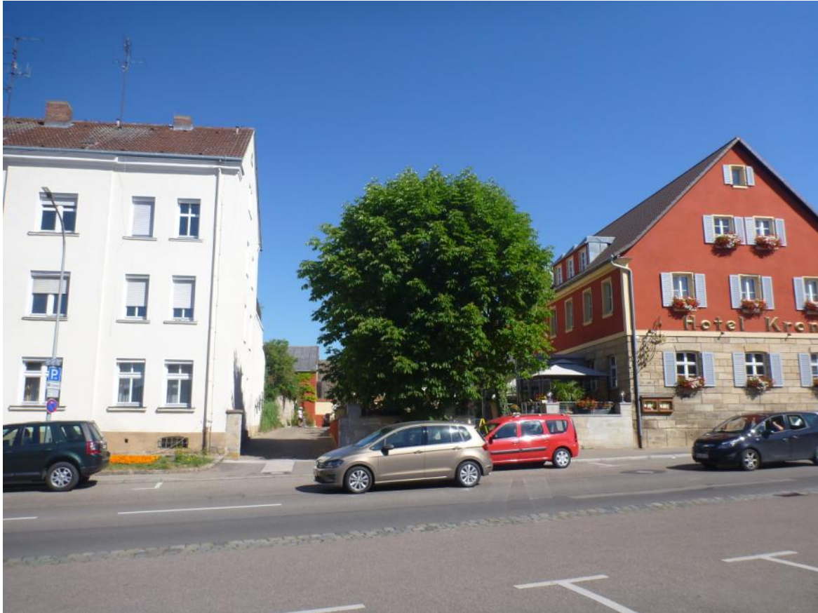
Abb. 7: Blick von der Nürnberger Straße Richtung Norden
