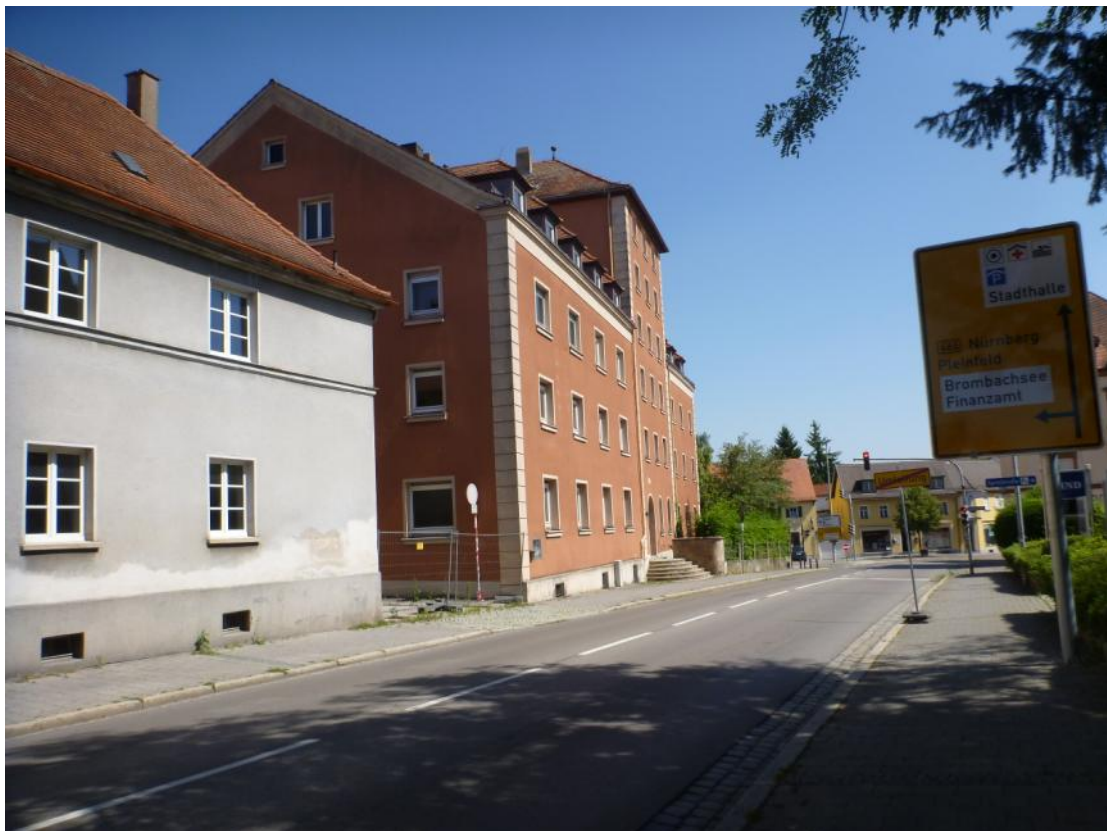
Abb. 8: Blick von der Bahnhofstraße Richtung Süden auf das Haus "Silo"
